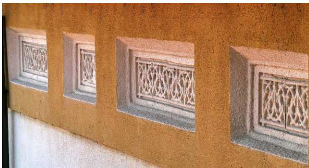
Детаљ фриза на фасади
