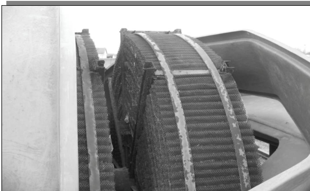
Slika 39. Biodisk van funkcije na mestu ispuštanja komunalnih otpadnih voda u Jaši Tomiću
